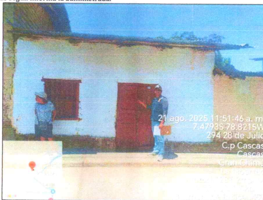
Inspección por parte del personal técnico
